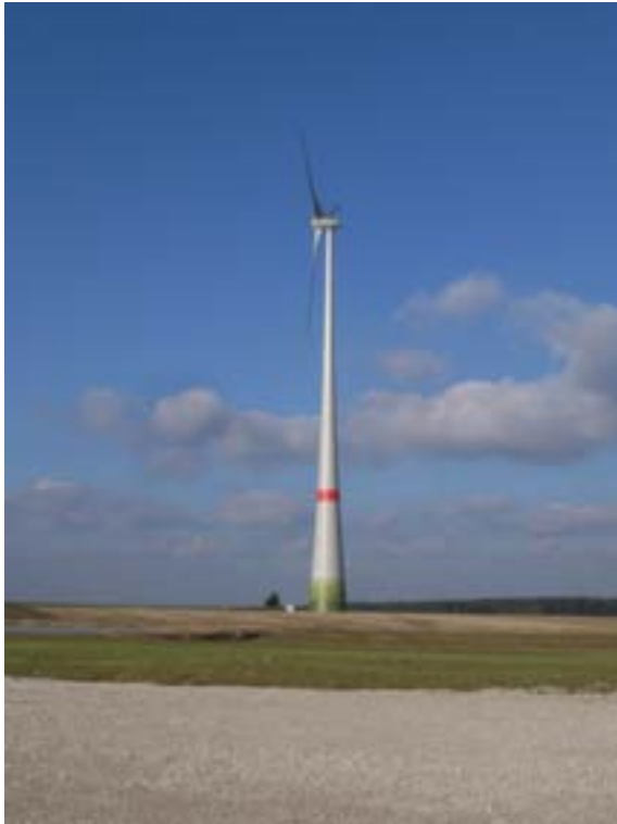
Abb. 6: 2 MW Windkraftanlage mit 138 m Nabenhöhe.
