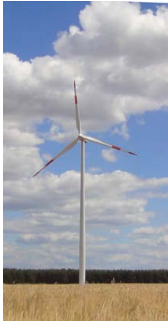
Abb. 13: Windkraftanlage der 2 MW Klasse.
